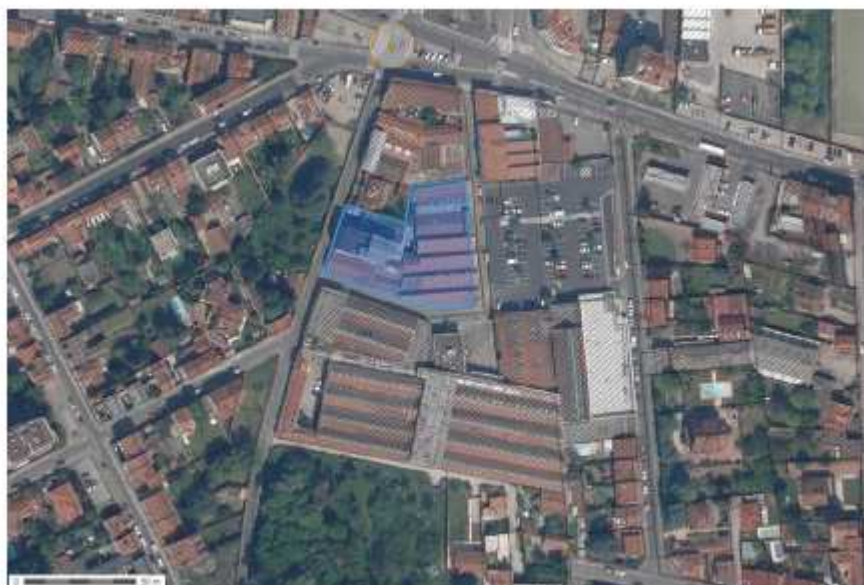
Figure 1.1 : Emplacement du site Lépine à Bron (source Géoportail)
